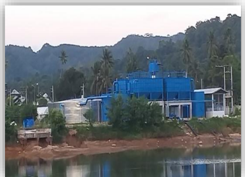
โครงการประปาภูเก็ต (สถานีผลิตน้ำประปากะทู้)
